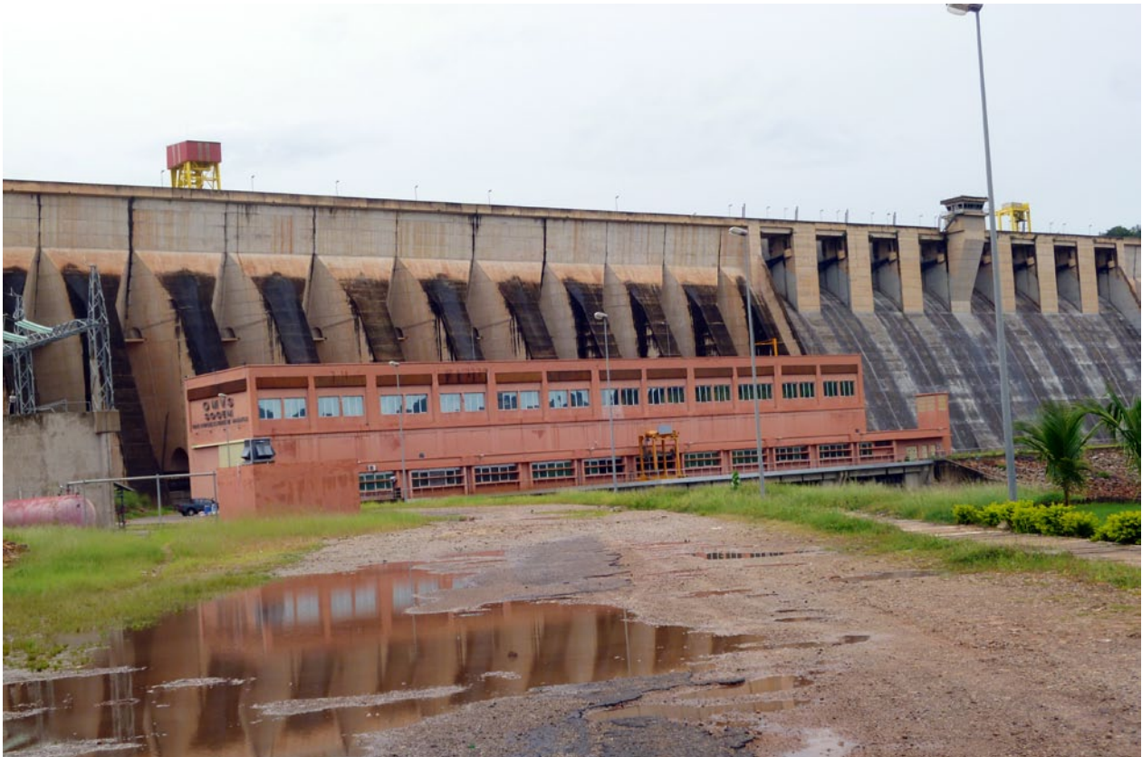
Manantali Energy Project (Mali)
